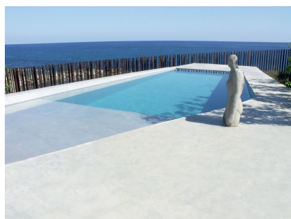
SISTEMA TECNOCEMENTO® POOL en exterior de vivienda privada en San Juan de Alicante
