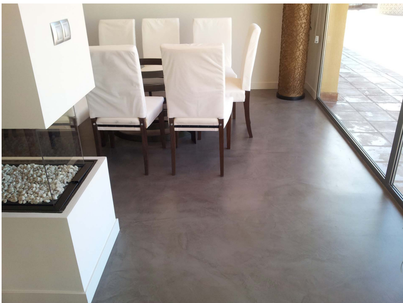
SISTEMA TECNOCEMENTO PLUS® sobre suelo de vivienda unifamiliar en Alcoy
