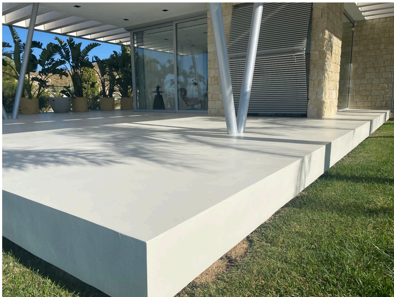
SISTEMA TECNOCEMENTO® HIGH TRANSIT en exterior de vivienda privada en Alicante
