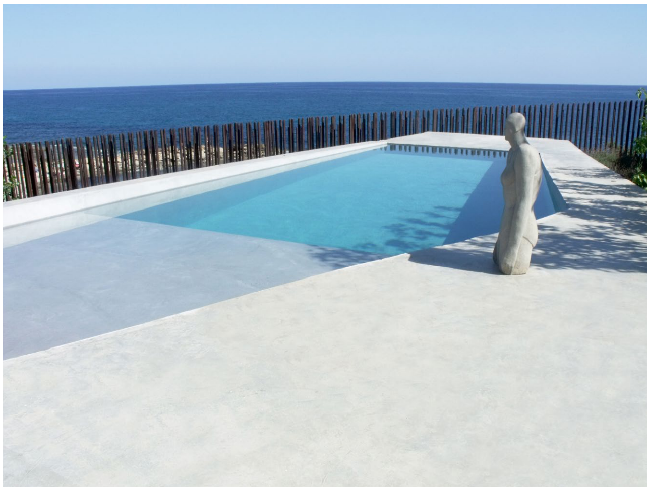
ΣΥΣΤΗΜΑ TECNOCEMENTO® POOL σε εξωτερικό χώρο ιδιωτικής κατοικίας στο San Juan de Alicante
