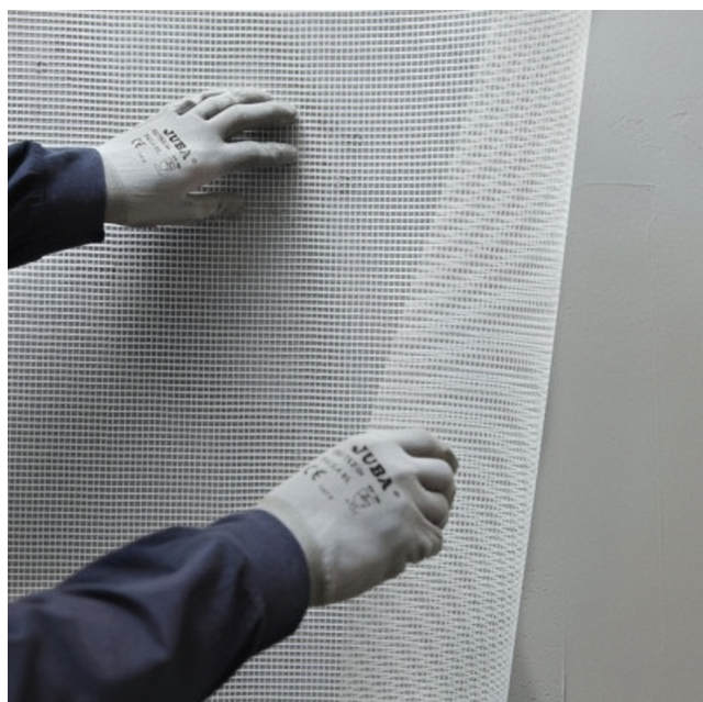
Preparación de soportes: colocación de malla antes de la aplicación.
